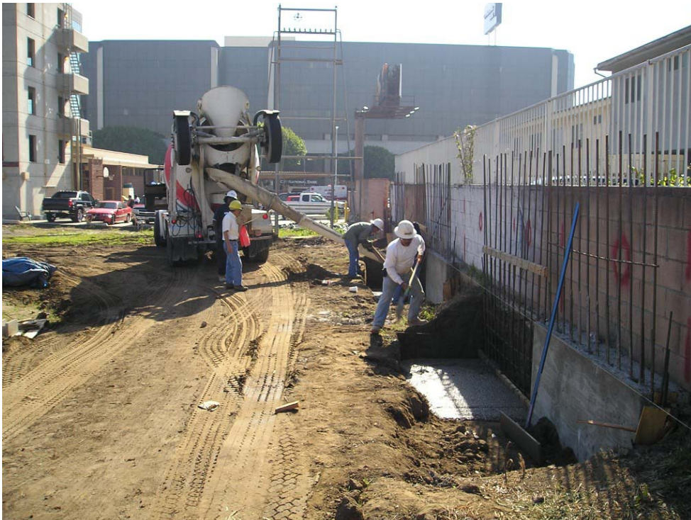
Concrete Pour for West Site Wall
